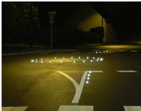
Dispositifs rétro réfléchissants utiles pour la sécurité routière. Ce dispositif peu coûteux est efficace et contribue à la baisse de la pollution lumineuse
